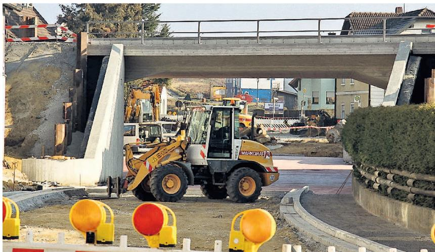
**NEUAUS –** Mit Hochdruck wird an der Fertigstellung der neuen Bahnunterführung in Neuhaus gearbeitet. Der besondere Schwerpunkt der Arbeiten liegt derzeit auf dem Bau der neuen Straße. Begünstigt durch das gute Wetter wurden bereits die Gehsteige gesetzt. Die Pflasterarbeiten sol-
